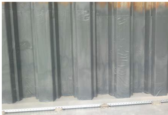
Гидроизоляция Обводного канала, Основание: бетон, металл, геотекстиль (Санкт-Петербург)
