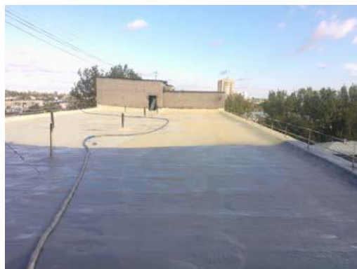
Гидроизоляция кровли центральной городской больницы, Основание: ППУ (Астрахань)
