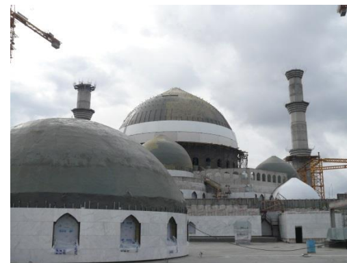
Кровля мечети, Основание: ППУ (Астана)
