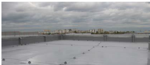
Гидроизоляция кровли завода Белая Дача, Основание: ППУ, рубероид (Н.Челны, Москва)
