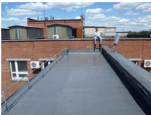
Гидроизоляция кровли завода, Основание: рубероид (Челябинск)
