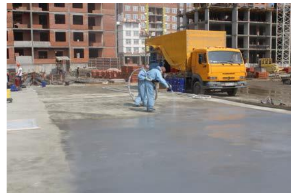
Гидроизоляция кровли подземного паркинга Ренова Строй групп, Основание: бетон (Екатеринбург)
